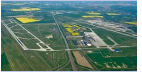
Schon früher waren hier Handelswaren unterwegs
