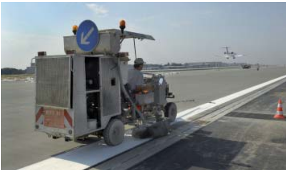
Markierungsarbeiten auf der neuen Landebahn
